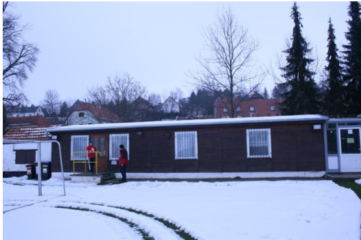
KJP II/Dach Sportplatz Möbisburg
