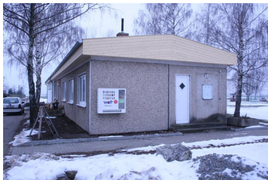
KJP II/Dach Sportplatz Schwerborn
