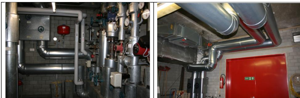
Bilder: Nahwärmeeinbindung Leichtathletikhalle und Eissportzentrum
