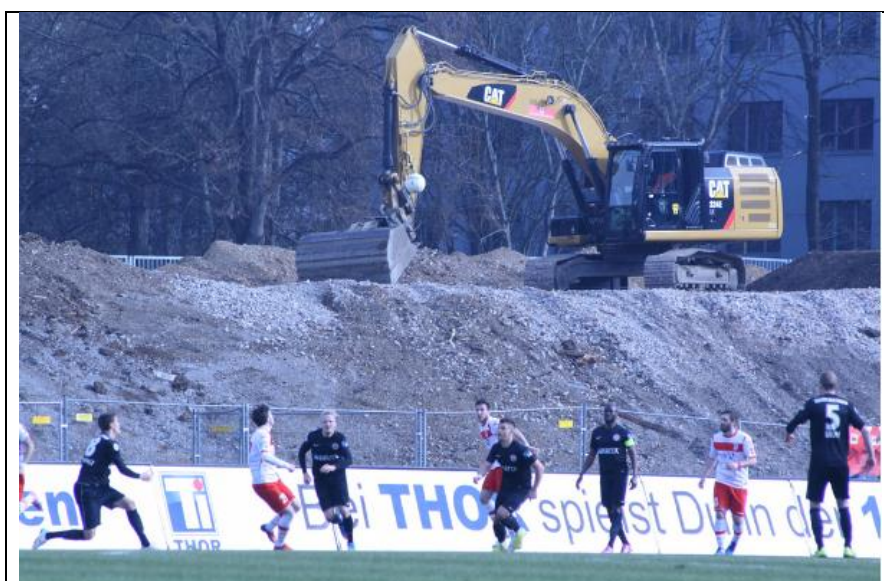
Umbau der MFA bei laufendem Sportbetrieb – hier Fußballspiel 3. Bundesliga FC RWE
