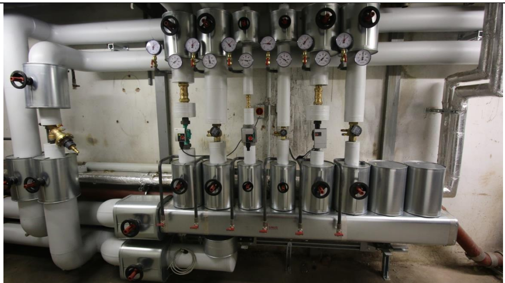
Bild: Bild zeigt den Neubauverteiler im Nahwärmenetz der alten Eishalle
