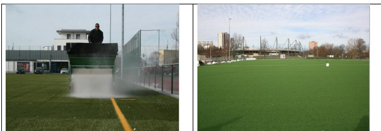
Bilder: Begünstigt durch die Witterungsbedingungen konnten doch noch 3 Kunstrasenplätze auf 2 Sportstätten im Jahr 2015 gebaut werden. Hier zu sehen: der Sportplatz am Wustrower Weg (erhielt 2 Spielfelder) und der Sportplatz "Am Nordpark"
