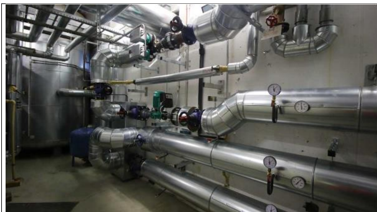
Bild: Instandsetzung technischer Anlagen in der Leichtathletikhalle
