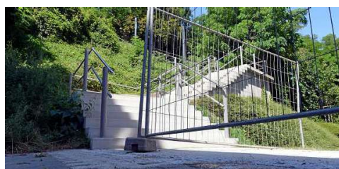
Die Treppe war bis Mitte August gesperrt. FOTO: MARCO SCHMIDT
