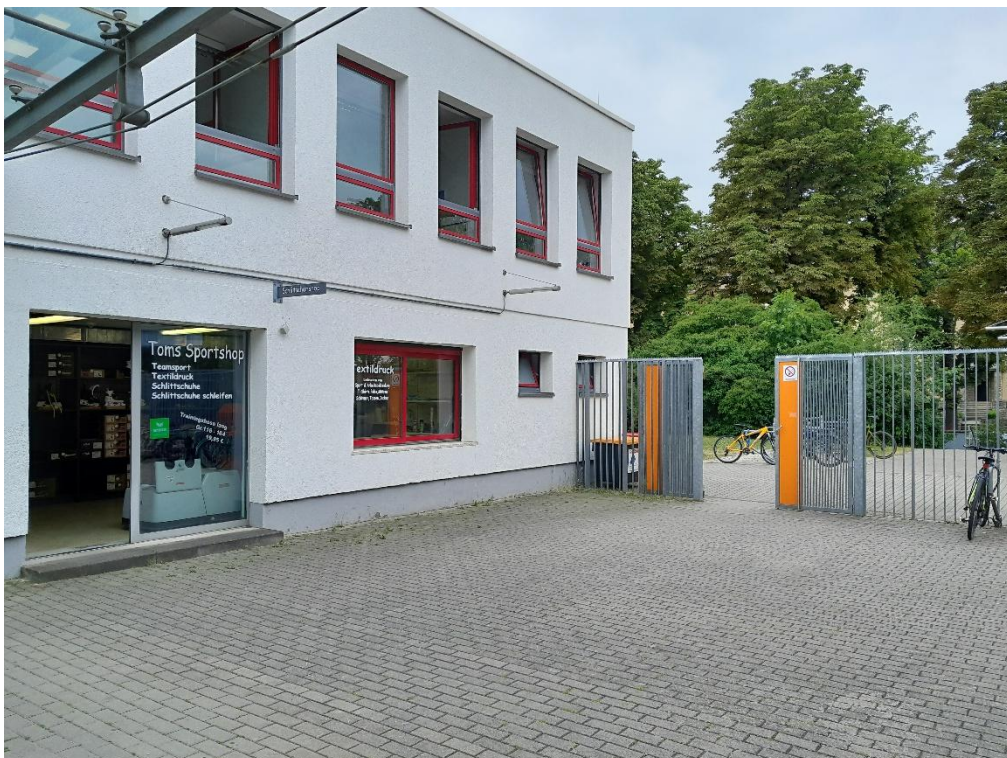
Zugang zum Laden (Außenansicht)
